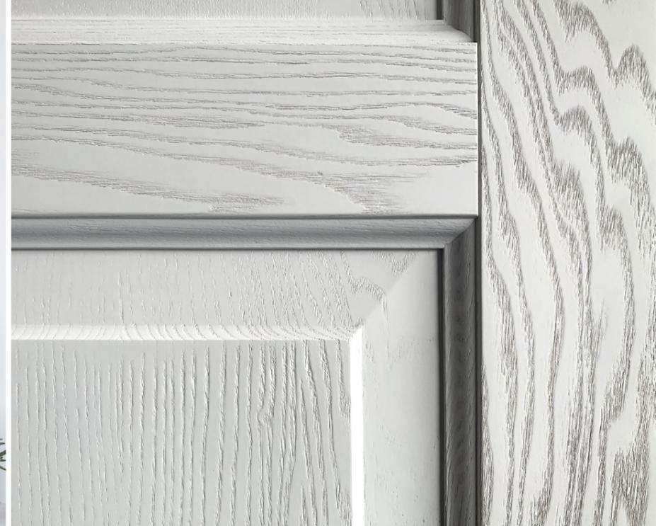
Il **laccato poro aperto** è un particolare sistema di verniciatura che lascia intravedere le caratteristiche della superficie in legno, così da notare ed apprezzare le naturali venature del legno che si presentano sempre diverse, a testimonianza dell'unicità e dell'esclusività della materia prima. Per questo è una finitura molto apprezzata dai più importanti brand dell'arredamento d'interni.
